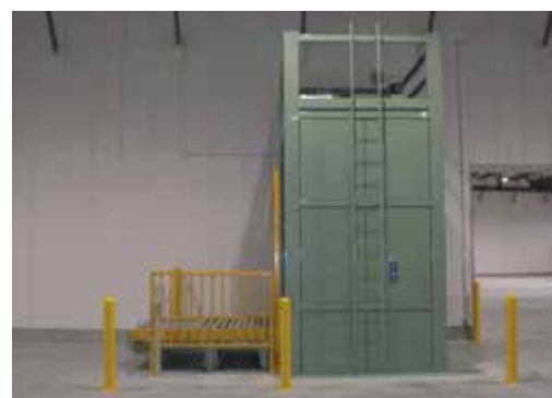
● 配外封板自立式塔体
