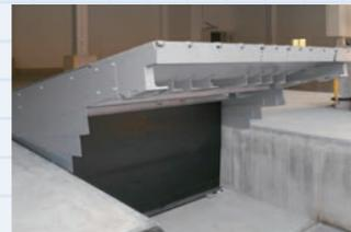
●トラック到着時にはボタン操作で荷台高さまで上昇し、安定したスロープをつくります。(傾斜角度9.5°、先端部スライド幅500mm)
