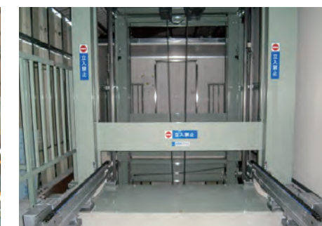
●専用パレットの送り込み装置はチェーンコンベヤです。
