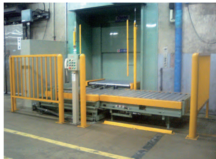
●エレベータ撤去後にオムニリフター入替え(NEDO対象商品)
